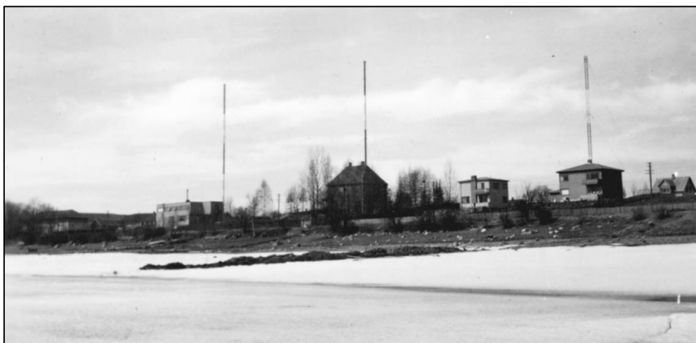
LKH Hamar Kringkaster 519 kHz sett fra Mjøsa ved Storhamarstranda med tre master. Den til høyre ble ferdigstilt 23.januar 1940. Foto: Digitalt Museum/Alex Lyche/Anno Domkirkeodden.
