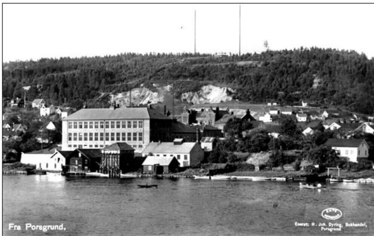
Bilde: 1466 LKP Porsgrunn Kringkaster, 2 forskjellige QTH. De to 60 meters mastene med 80 meters mellomrom og senderhus på plass på Borgeåsen 1927. Skiensfjordens mekaniske fagskole i forgrunnen. Prospektkort: Joh.Dyrings bokhandel.
