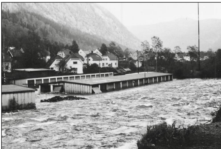
Storfloem 1967 på Rjukan. Bildet viser senderanlegg #3 for LKR. Radiomast på elvbredden i Blindtarmen, med senderhuset bak stolpen ved garasjene. Bilde: Ukjent.
