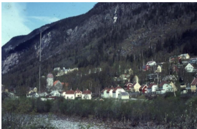
Blindtarmen, Rjukan. Lokalisering #3 for LKR 1954-1976(1983). Mast med vertikalantenne LKR ved elvebredden, og senderhus ved enden av bebyggelse til h. i bildet. Bilde: Sverre Solberg, ca.1960.
