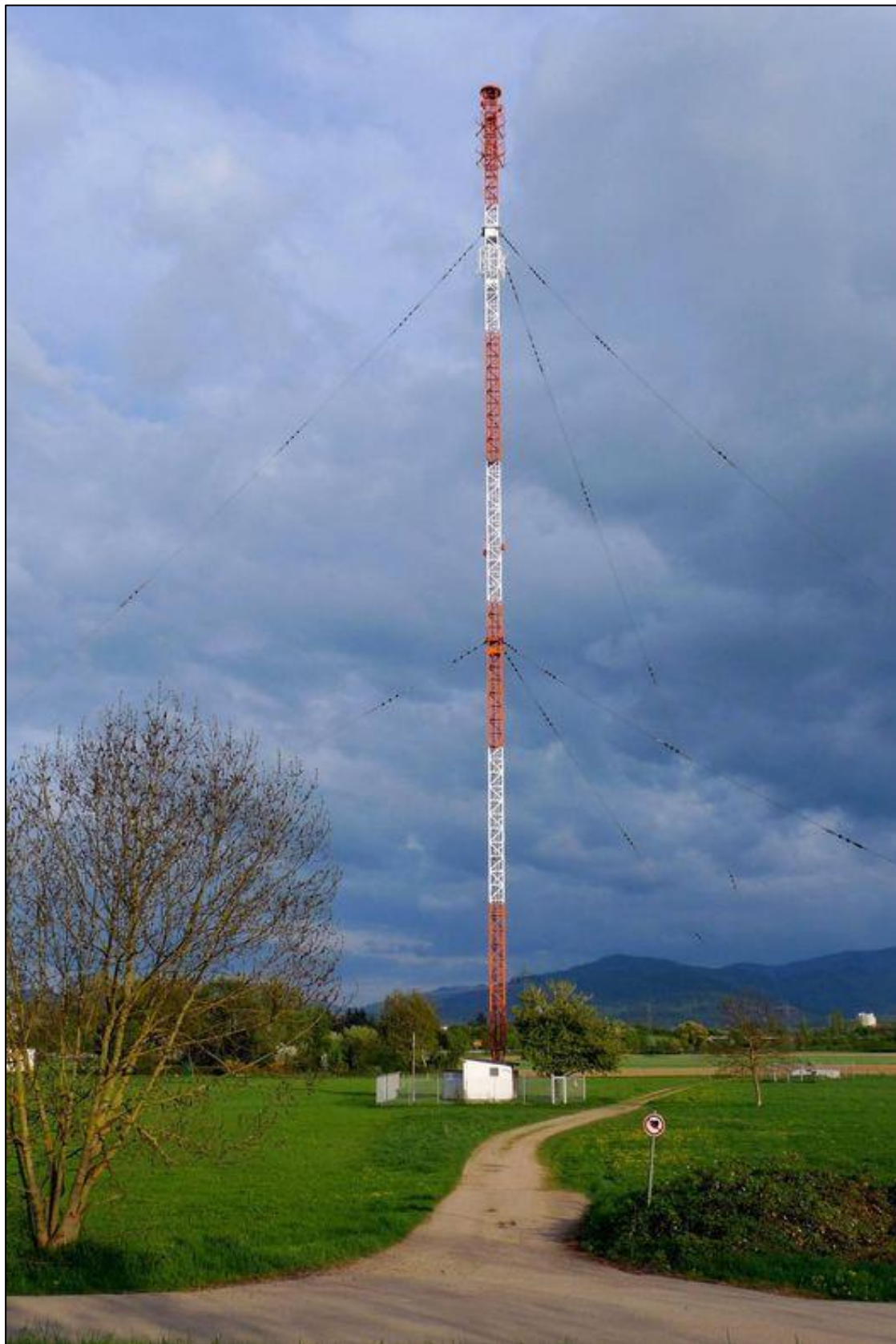
92 m hög självbärande stålgermest för mellanvågssändaren Freiburg-Lehen, f d Südwestfunk. Byggår 1945, mellanvågen nedlagd 2012. Sedan dess har masten fungerat som antenn för VHF och DAB+ för Südwestrundfunk. (Siegfried J. Frank, A-DX 29.3.2022)
