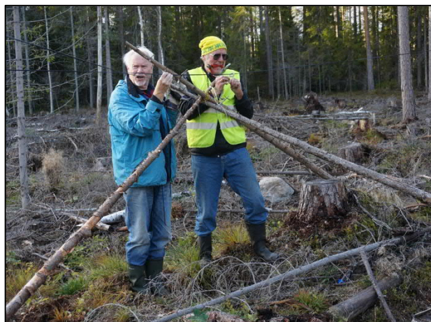
T.v. RLH kontrollmäter tråden som ska användas för vår nya 300-gradare. DAD övervakar arbetet. T.h. JE och DAD reser ytterligare en tripod som ska hålla antennen uppe, utom räckhåll från älgar mm
