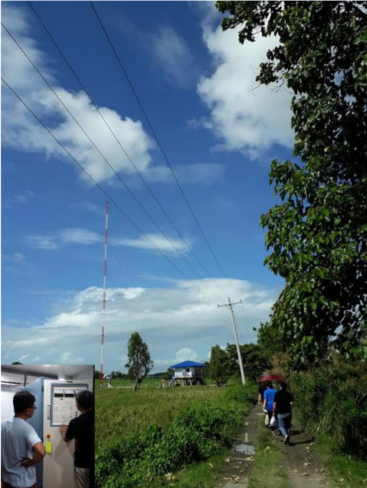
Ny sändare och mast installerad.
