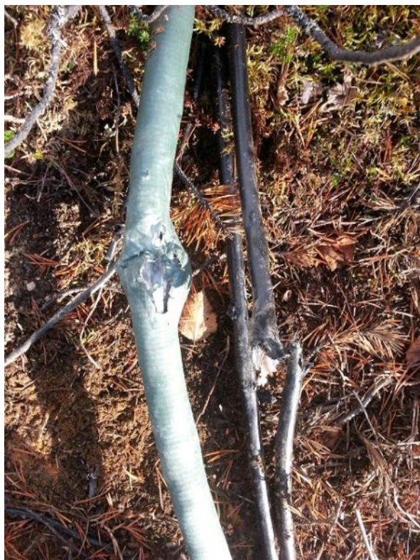
På bilden syns slangen som innehåller två skadade RG58-koaxer, de två RG215 varav en skadad på yttre manteln och den andra helt av. Dessutom skulle här också finnas två friliggande RG58 men de är helt avslitna och ändarna utspridda. Foto: Bosse Olofsson
