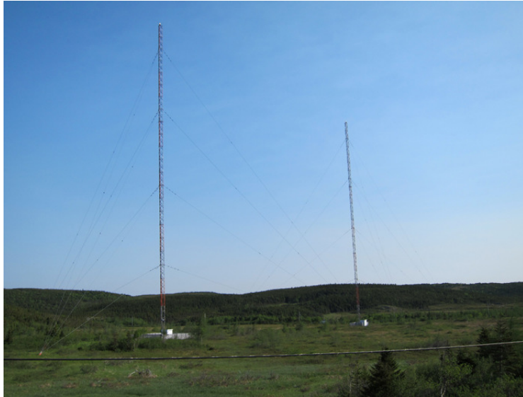
Antennene til CBNA-600 kHz
